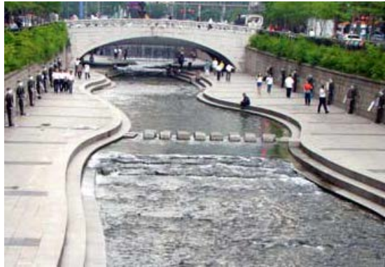
▲圖 02.首爾清溪川河岸建設
